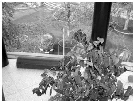
Slika 7. Vazdušni izvor za ventilaciju, do-grevanje i pothlađivanje prostorije bez pojave promaje
