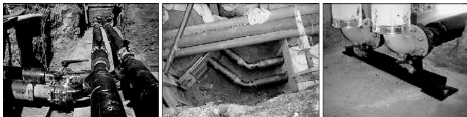
Slika 5. Instalacija cevi od fiberglasa
