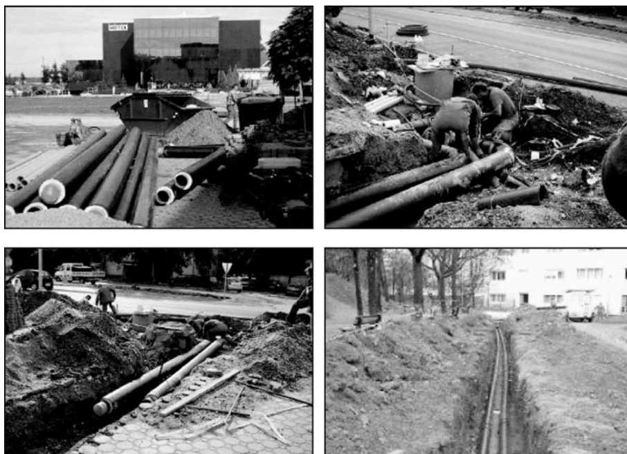
Slika 7. Izgradnja i montaža toplovoda u Lendavi (Slovenija)
